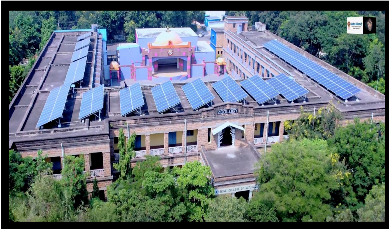
Solar panels in AU
